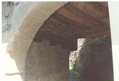
Foto 2: vista del sottopasso ad arco.
