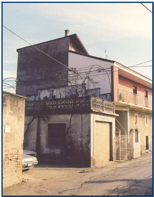
Foto 1 : vista dalla provinciale
