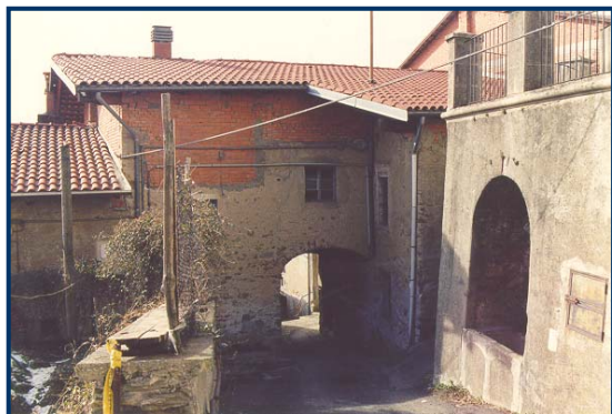
Foto 1: vista dall'alto verso il sottopasso
