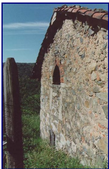
Foto 3: vista dalla strada comunale
