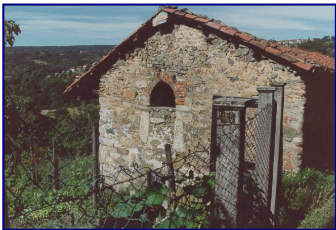
Foto 1: vista dalla strada comunale
