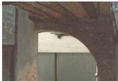
Foto 3: vista del sottopasso ad arco.
