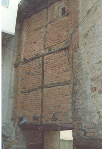
Foto 1: particolare del retro; struttura lignea e tamponamento in muratura.
