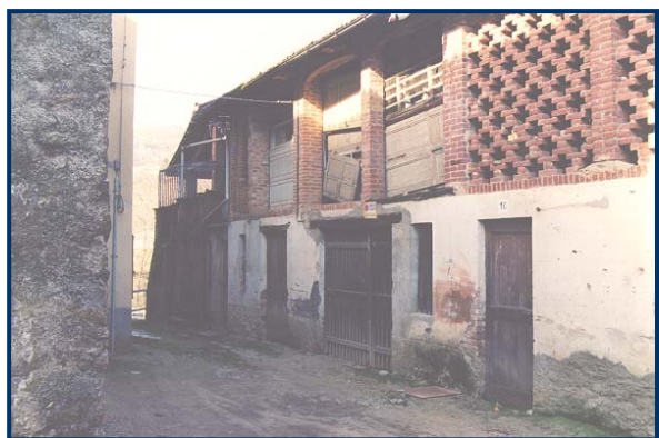
Foto2: vista dalla strada comunale
